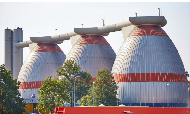
ABB. 4 Faultürme der Kläranlage Freiburger Bucht.
