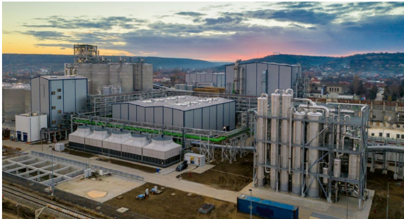
ABB. 3 Industrieanlage für die Produktion von Bioethanol der zweiten Generation. In dieser Anlage produziert Hefe Ethanol aus Lignozellulose, etwa aus Stroh. Foto: Clariant.
